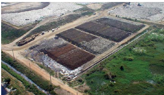
MBT施設におけるバイオドライイング場 (ピッサヌローク)
