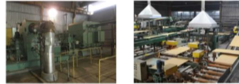
バイオマス発電施設
