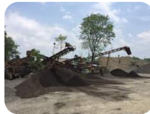
写真1 アスファルト廃棄物
