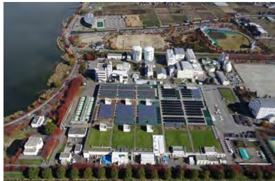
長野県/岡谷酸素/自然エネルギー信州ネット おひさまBUN・SUNメガソーラープロジェクト
