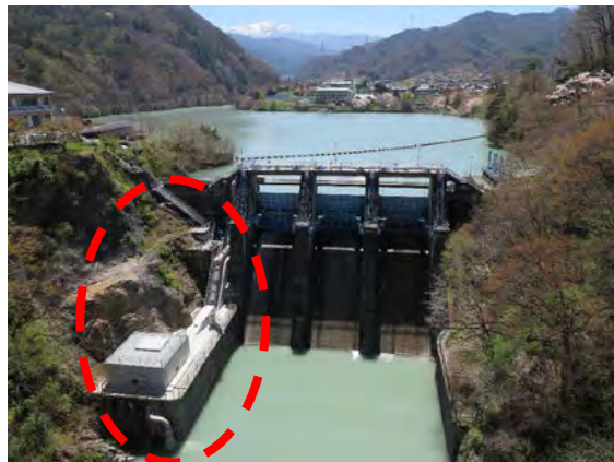
長野県企業局高遠さくら発電所 (円内/維持流量活用の小水力発電)
