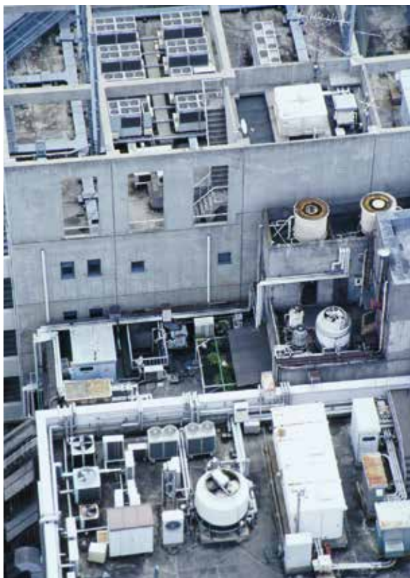
図 40 業務部門において冷暖房及び給湯器は灯油を大量に消費している。
