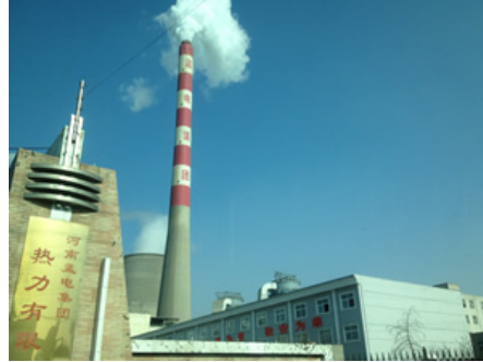
河南省の石炭火力発電所（2016年1月、筆者撮影）
