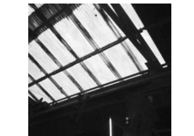
半透明シートから太陽光を取り入れた作業場
