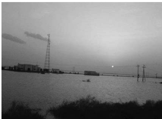
洪水に見舞われた発電所 (Copyright：筆者)
