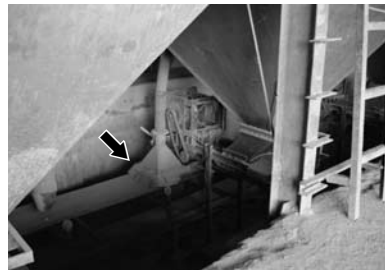
ダスト吸引フードにゴムカバーを設置
