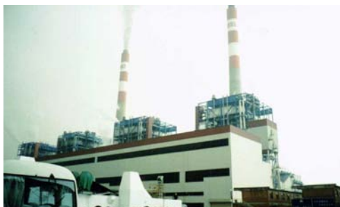
写真1. 深せん市西部電力有限公司訪問 / 海水脱硫工法使用 (98年6月5日)
