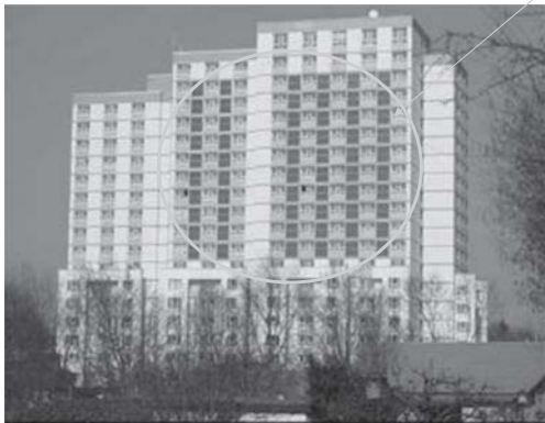
写真 ドイツフランクフルトの大規模集合住宅 (コレクター面積:252.1m 2 ) 出所:Solarthermie-2000 プログラム2
