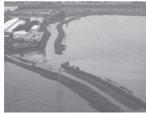
洪水被害の事例 (国土交通省中部地方整備局提供)
