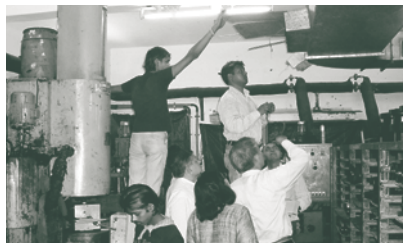
インドのパイロット事業実施サイトで設備を確認
