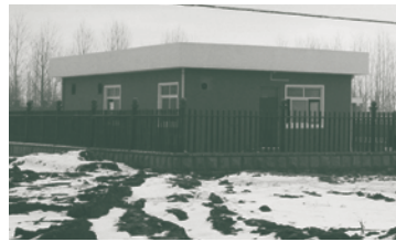
山東省威海市に建設した分散型生活排水処理施設の外観
