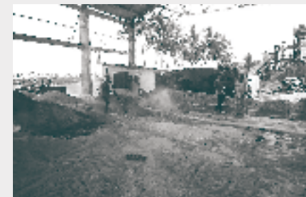
インド南部のバイオマス利用施設
