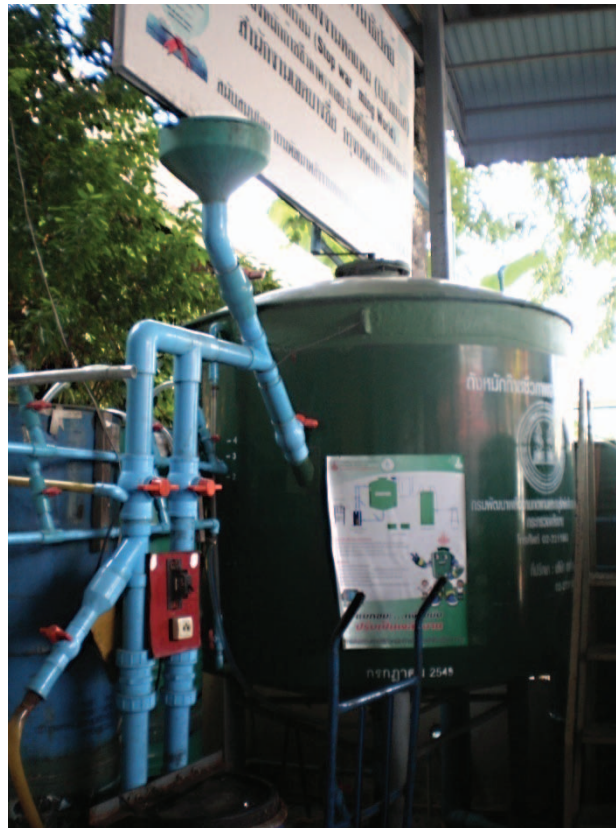
รูปที่ 4.4 ถังย่อยสลายแบบไร้ออกซิเจนขนาดเล็ก
