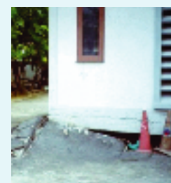
Subsidencia del terreno en Bangkok Foto: Cortesía de AIT
