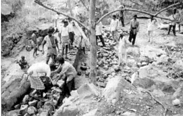
溜池の建設 Construction of check-dam ( http://www.narmada.org から転載、 Courtesy of www.narmada.org )
